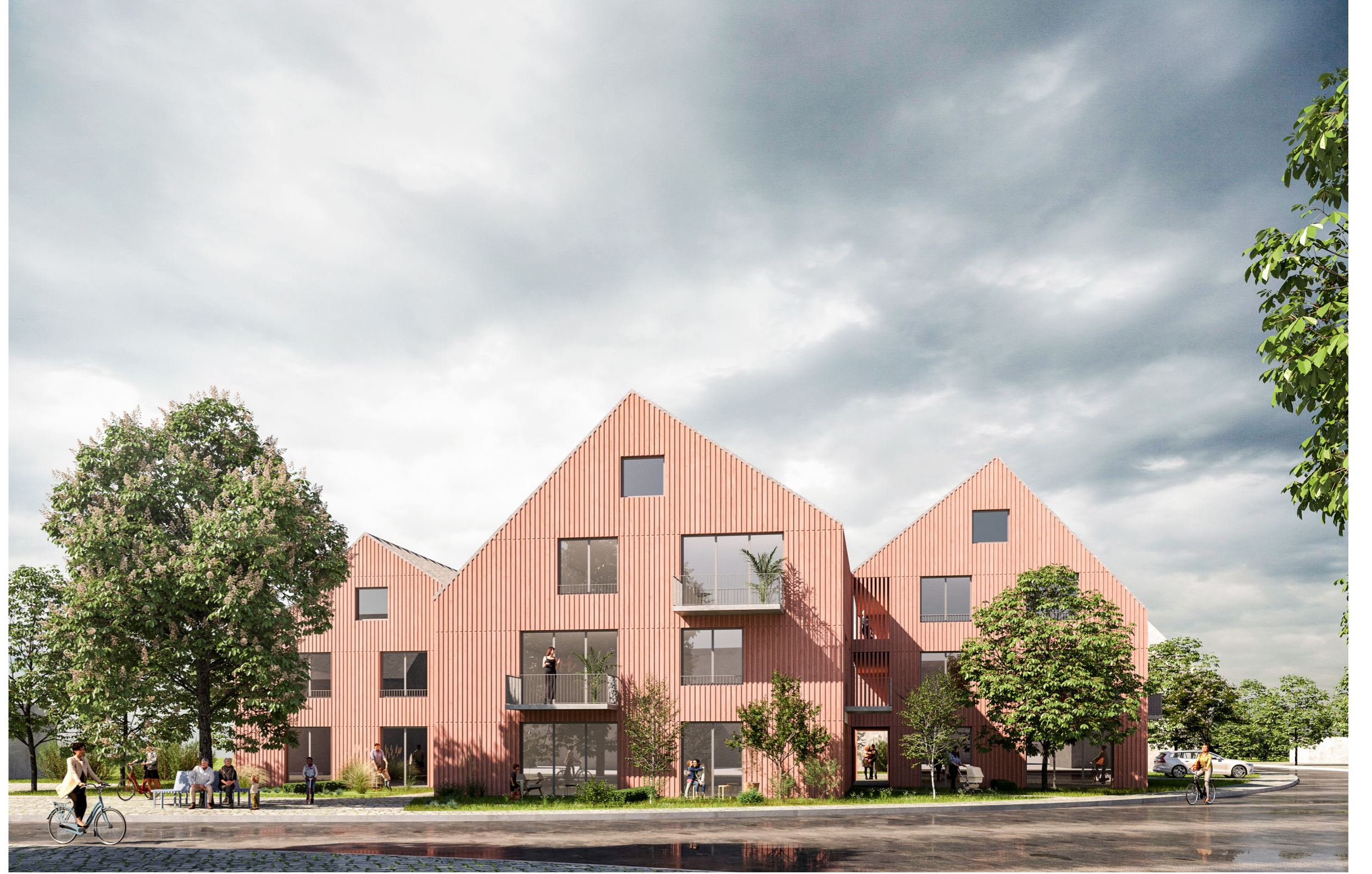
Blick von Höfener Straße / Ecke Eduardstraße
